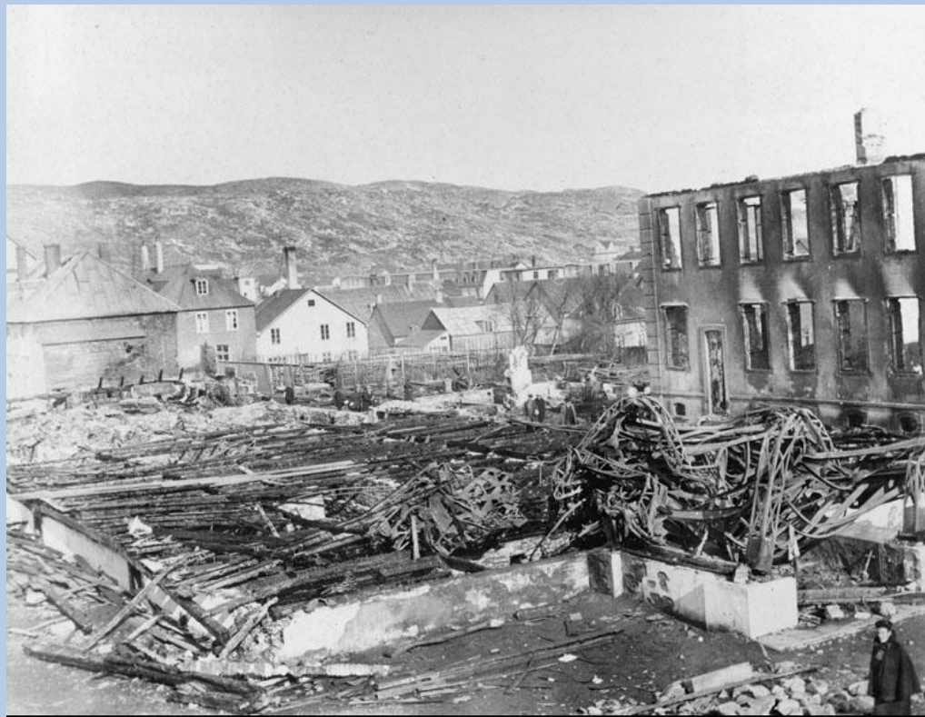
165 - Incendie de l'Eglise et du palais de Justice (1er nov.). - Saint-Pierre - 1er nov. 1902
