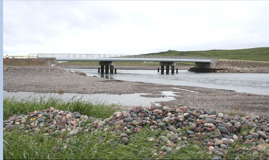
Nouveau pont de Miquelon – goulet du Grand étang : 12 juillet 2007
