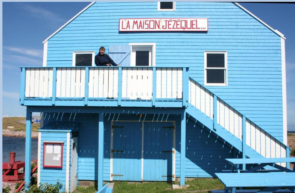
La Maison Jézéquel, restaurée – 20 août 2007
