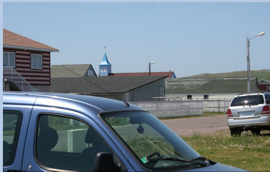
Nouvelles constructions, - Miquelon - 4 juillet 2007
